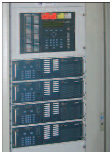
Przykład wielostrefowego zespołu central gaszenia
